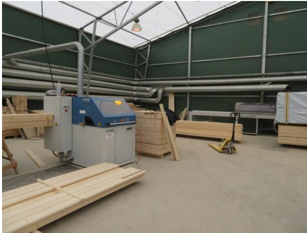
Foto 16 PVC 2 halli sisevaade
