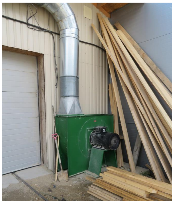
Foto 11 Suure halli ja höövelitsehhi pneumotransport.
