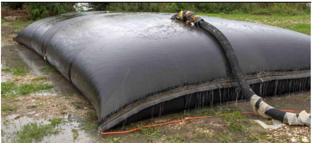
Joonis 4. Pumbatud muda käitlemine geokotis ( https://progrroupe.net/... ).
