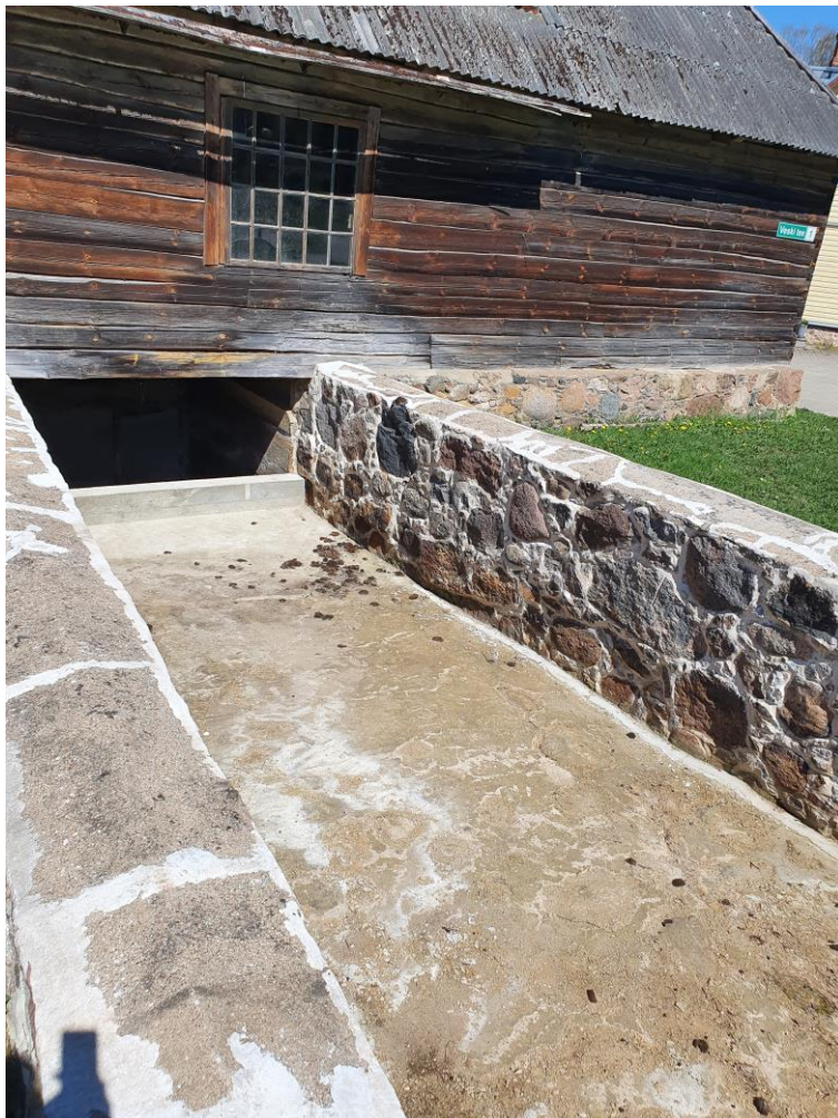
Foto 3. Rosma vesiveski turbiinikanal pärast 2020. aastal teostatud renoveerimist (Kobras AS, 12.05.2021).
