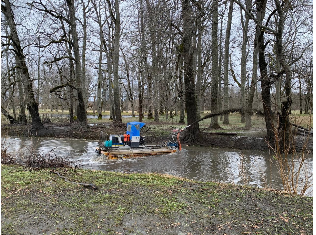
Joonis 3. Mudapumbaga amfiibmasina kasutamine tiigi puhastamisel (fotol on amfiibmasin Truxor, http://preisov.eehool.ee/... ).
