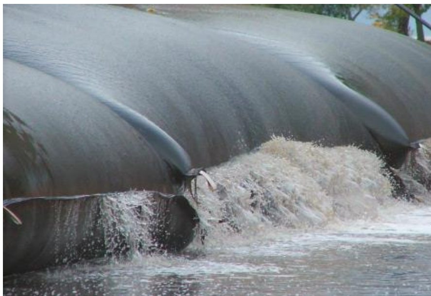
Joonis 8. Geokoti kasutamine järvest pumbatud muda veetustamiseks ( https://www.geosolutionsinc.com/products/erosion-control-geotube.html ).
