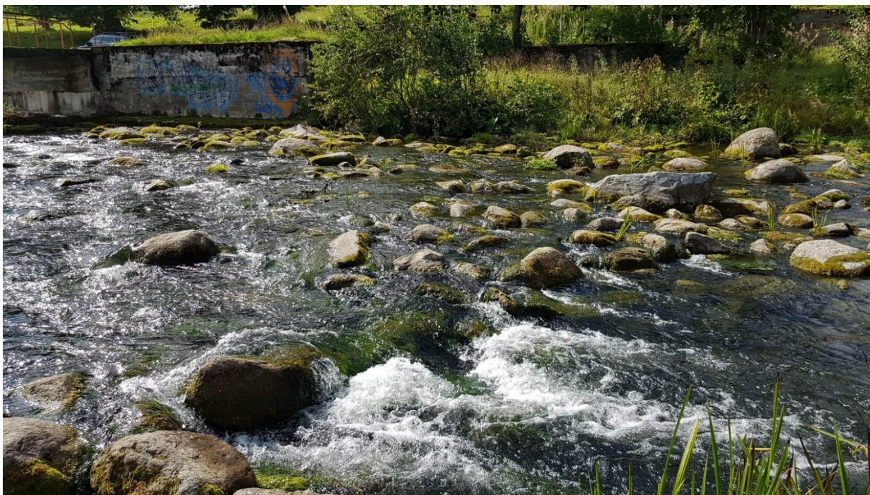
Joonis 5. Tapa kärestik-kalapääs Valgejõel (Marko Visse, 2021).
