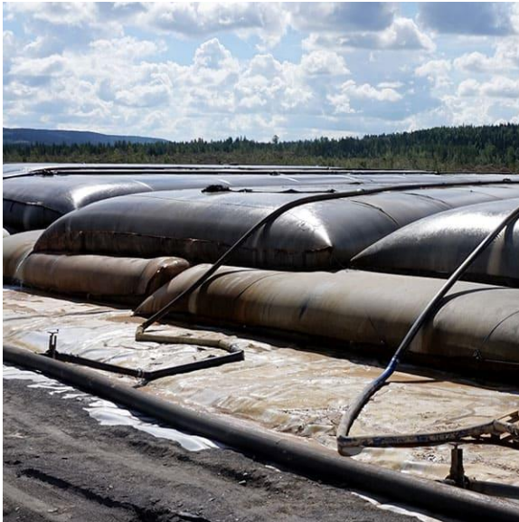
Foto 10 ja 11. Geotubeid täidetakse muda-vee seguga (foto projekteerimisbüroo Maa ja Vesi tööst nr 141050 ja https://www.geosynt.fi/tuote-osasto/geotubit/ ).
