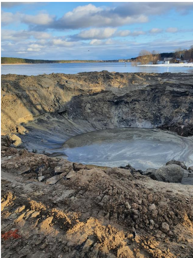
Fotod 3 ja 4. Narva jõe kaldapiirkonda rajatud süvend reoveekanaliseerimise avarii väljalasutõrjumise toru ühenduskaevu paigaldamiseks ning paigaldatav avariiväljalasutõrjumise toru (tänapäevaks paigaldatud) (fotod: Kobras OÜ, 18.02.2022).
