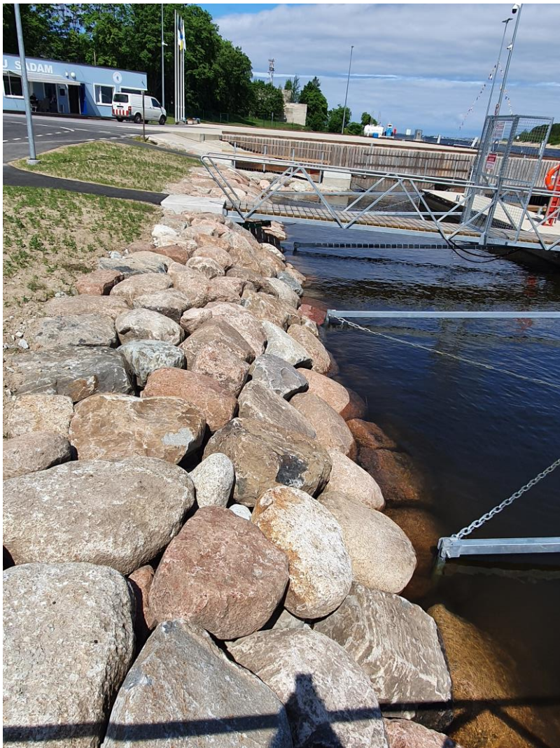
Foto 1. Narva-Jõesuu sadama esimeses ehitusetapis (2022. aasta kevadel) rajatud kaldakindlustus, ujukai kinnitused ja taamal paigaldatud uus ujukai (Kobras OÜ, 17.06.2022). (foto: Kobras OÜ, 17.06.2022).
