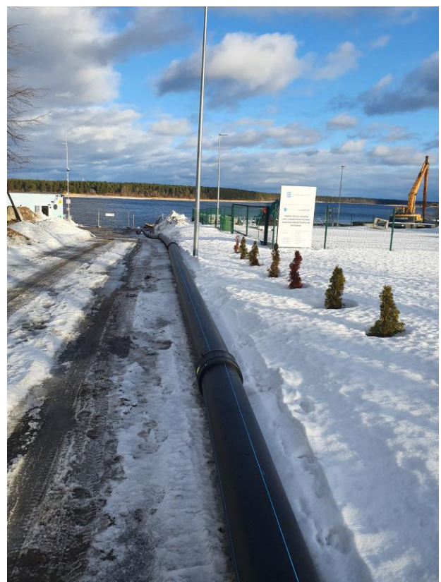
Fotod 3 ja 4. Narva jõe kaldapiirkonda rajatud süvend reoveekanaliseerimise avarii väljalasutõrjumise toru ühenduskaevu paigaldamiseks ning paigaldatav avariiväljalasutõrjumise toru (tänapäevaks paigaldatud) (fotod: Kobras OÜ, 18.02.2022).
