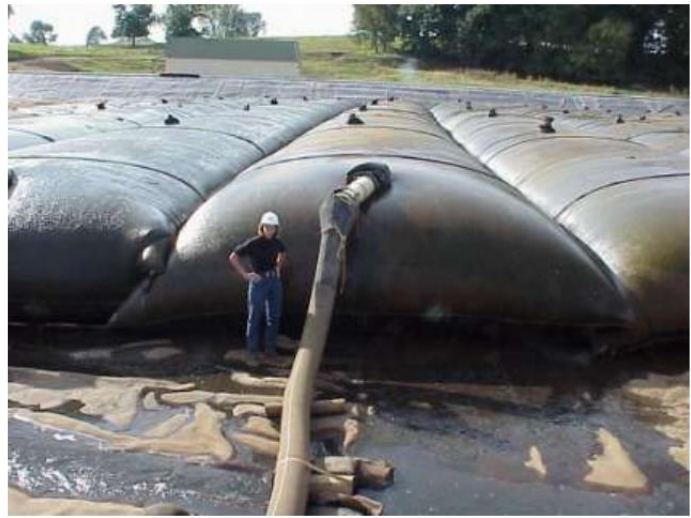
Foto 10 ja 11. Geotubeid täidetakse muda-vee seguga (foto projekteerimisbüroo Maa ja Vesi tööst nr 141050 ja https://www.geosynt.fi/tuote-osasto/geotubit/ ).
