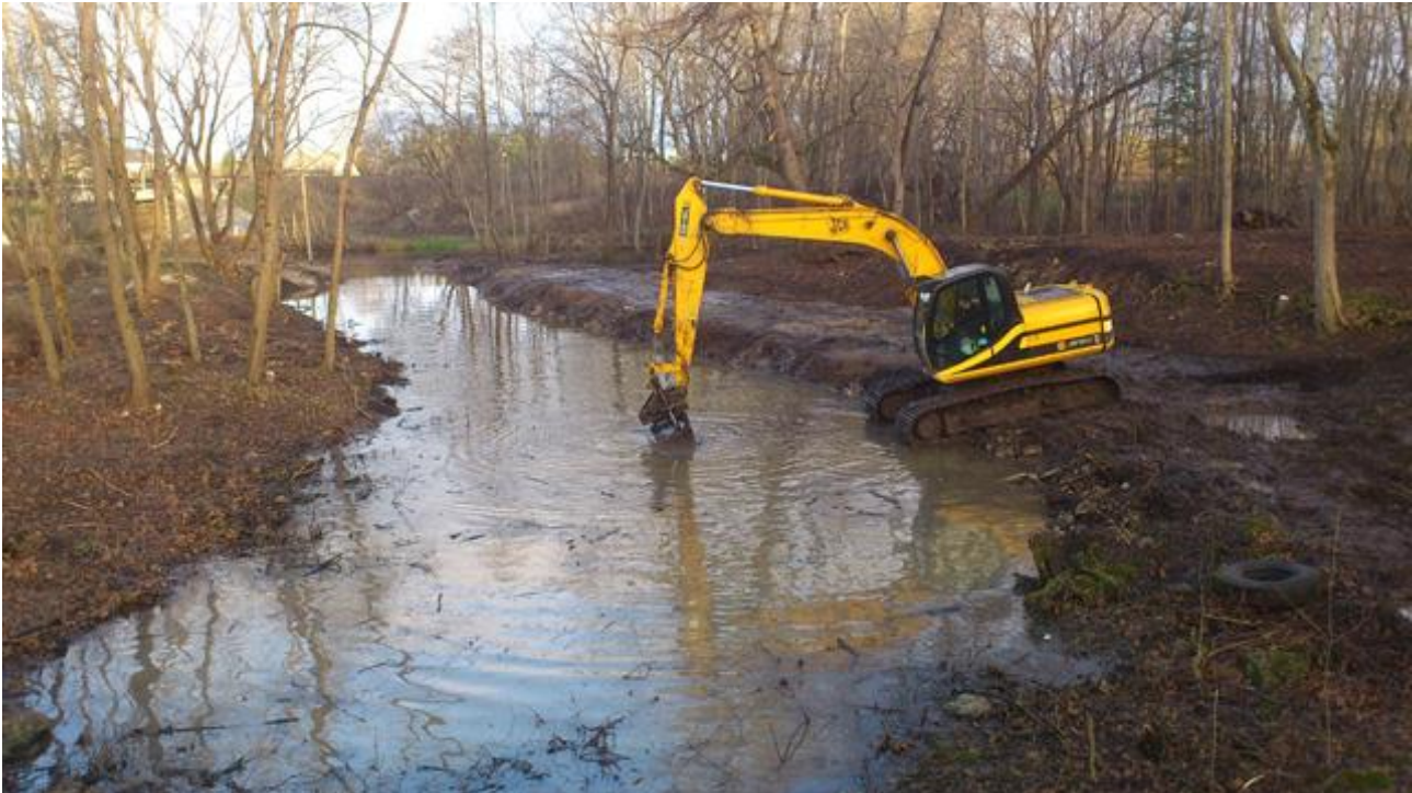
Foto 5. Veekogu puhastamine/süvendamine ekskavaatoriga ( http://preisor.veehool.ee/ )
