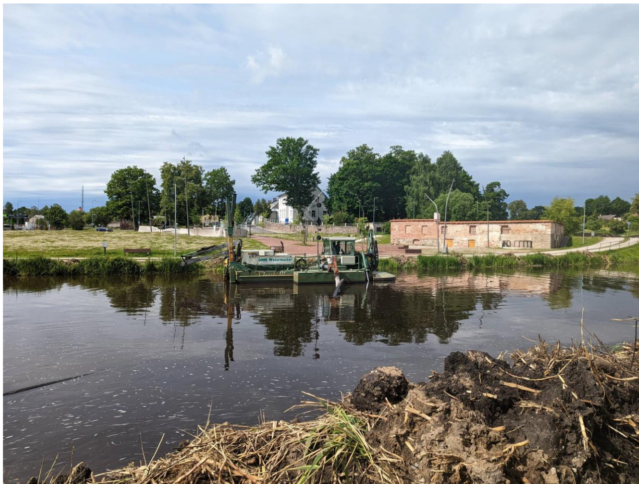
Foto 8. Muda pumpamine Watermaster pinnasepumbaga (foto: Kobras OÜ, 19.06.2022. Objekt: Valga linnas Vesikijärve puhastamine).
