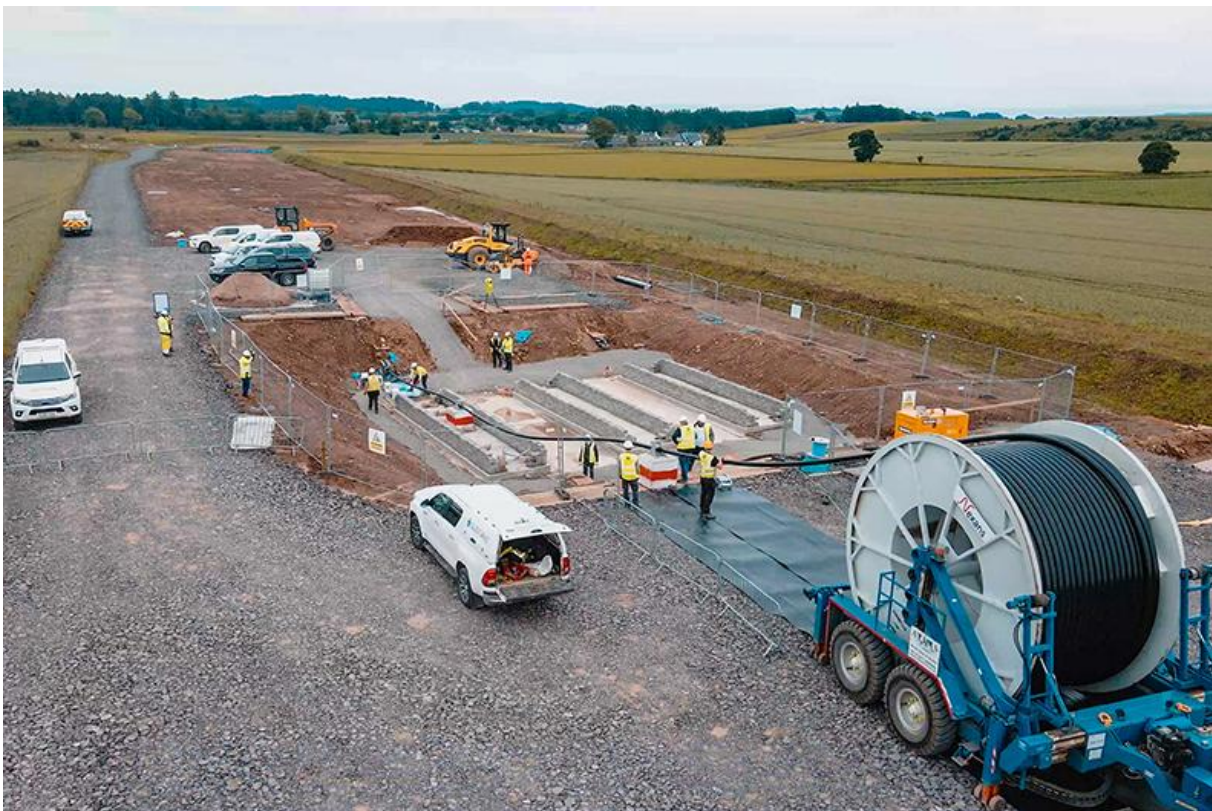
Joonis 2.3.4.4. Mere- ja maakaabli TJB ühendus paikneb merekaabli maabumiskoha läheduses. Allikas: SSE Renewables, Seagreen meretuulepark (1,1 GW), Šotimaa.
