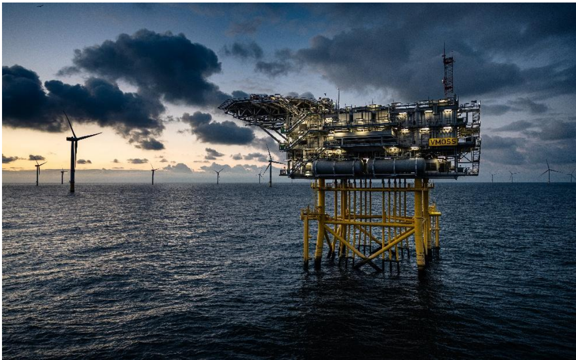
Joonis 2.3.4.2. Merealajaam (Veja Mate (402 MW), Saksamaal, arendatud Copenhagen Infrastructure Partners (CIP) poolt).
